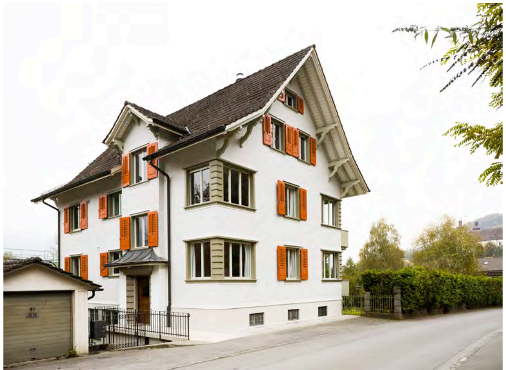
NOROSTFASDADE MIT EINGANGSBEREICH
