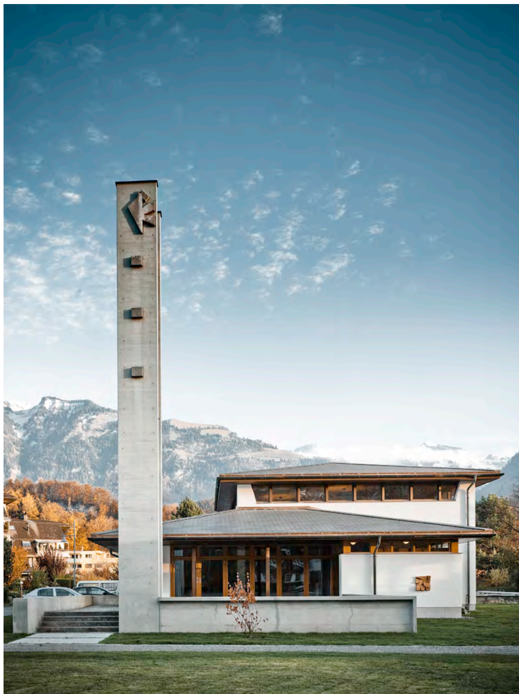
NORDWESTFASDADE MIT GLOCKENTURM
