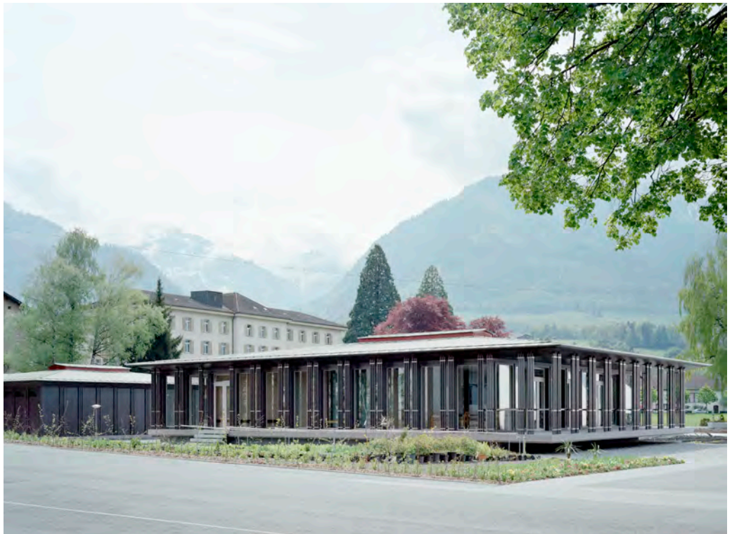
NORDWESTFASSEDE HAUPTGEBÄUDE UND NEBENGEBÄUDE
