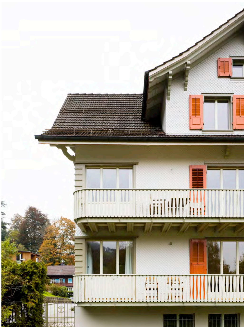
GARTENFASSADE MIT NEUER BALKONSCHICHT
