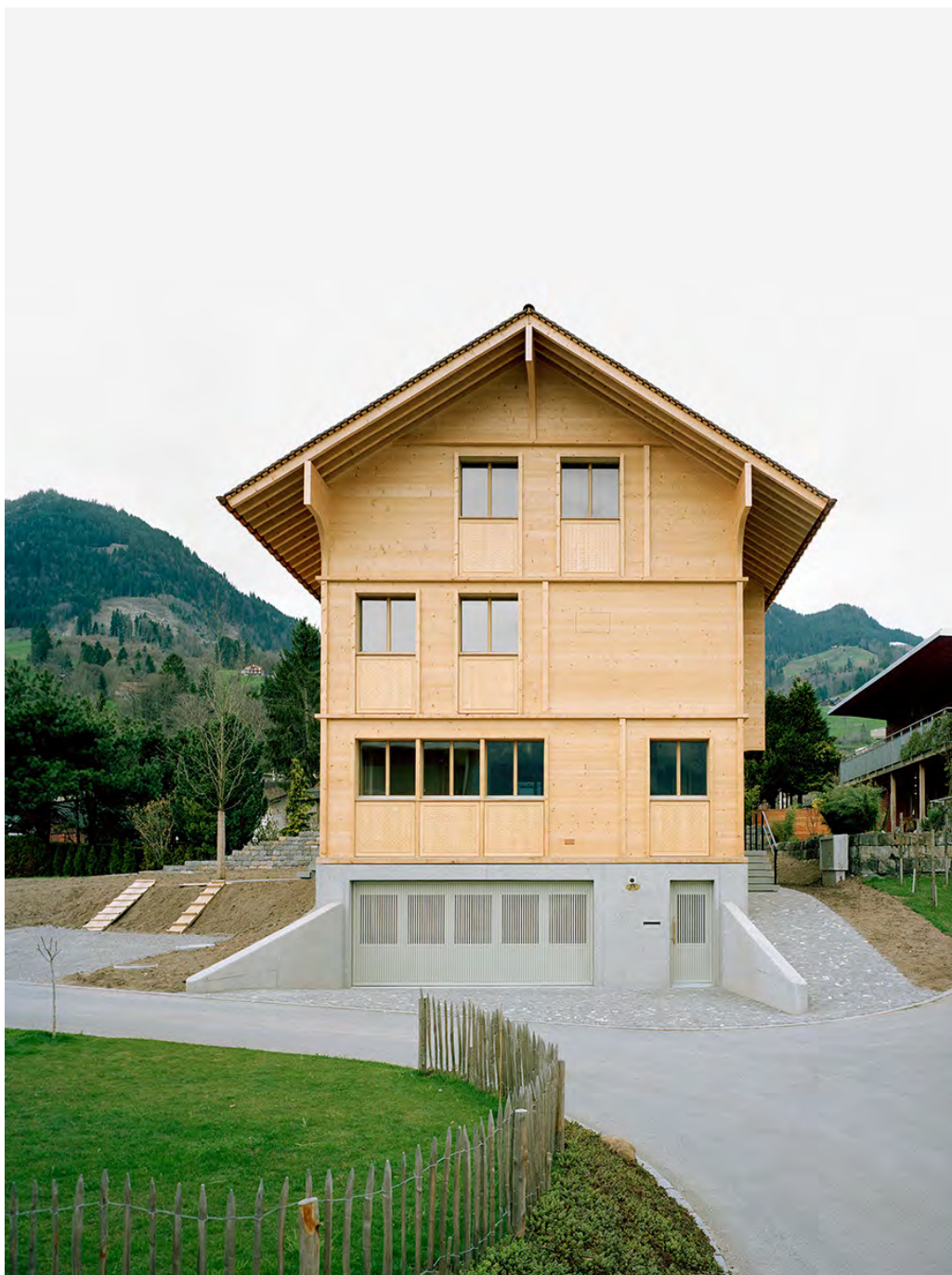
TALFASSADE MIT ZUFAHRT
