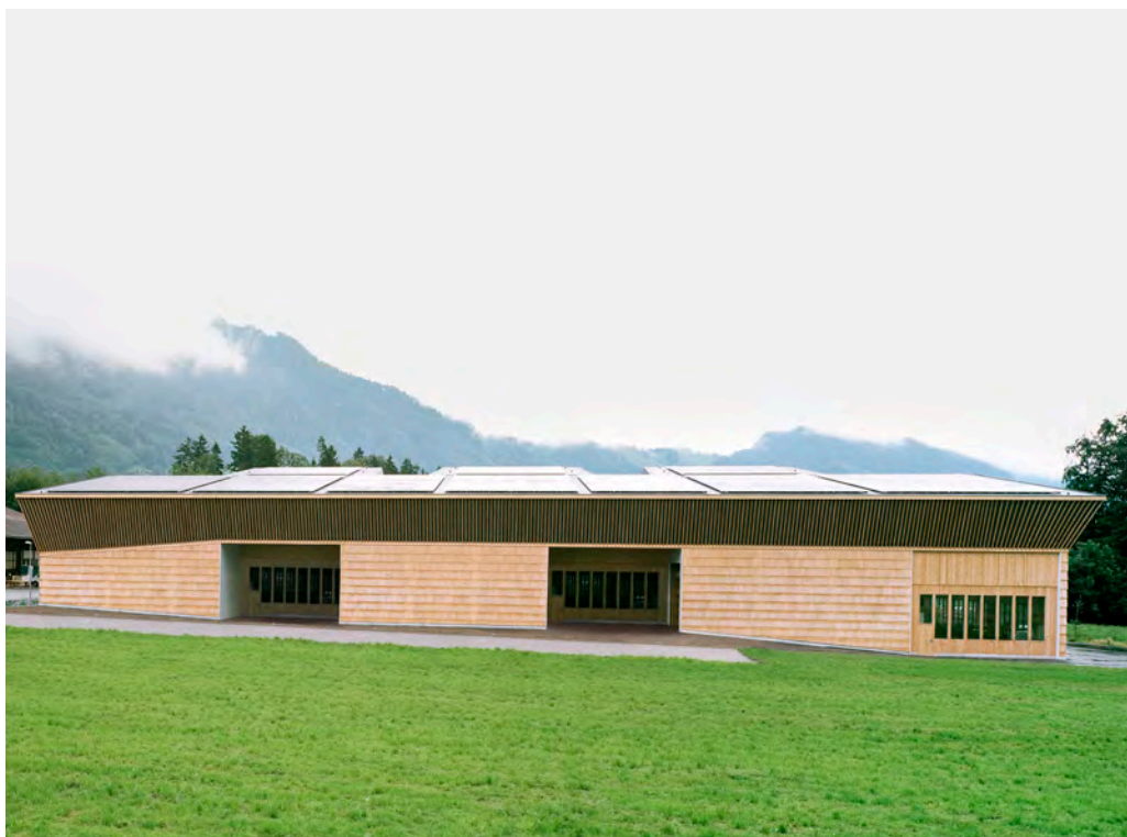
LÄNGSSFASSADE MIT ZUGANGSTOREN
