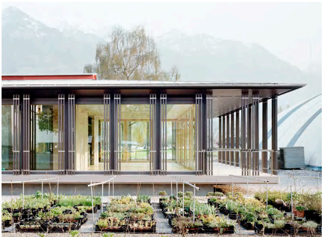
FLIESSENDER ÜBERGANG ZWISCHEN INNEN UND AUSSEN
