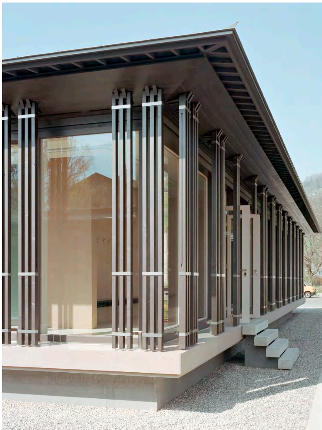
HAUPTGEBÄUDE MIT HOLZLAMELLENKLEID
