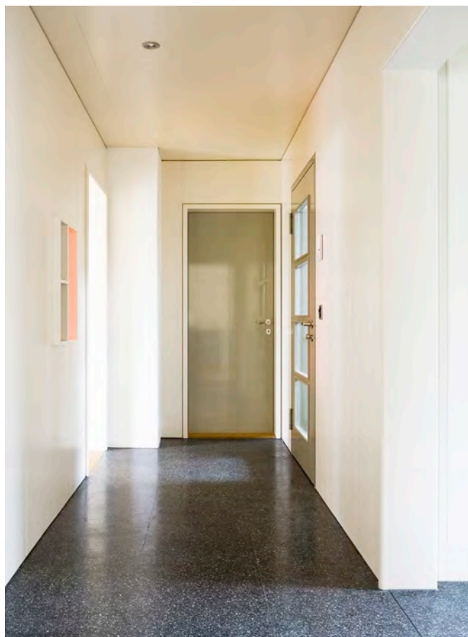
TERRAZZOBODEN UND NEUE WANDTÄFER IM KORRIDOR ERDGESCHOSS
